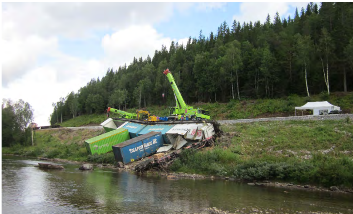
GANADOR DEL PREMIO 2020 GRÚAS TELESCÓPICAS, CAPACIDAD DE IZADO INFERIOR A 120 TONELADAS - KYNNINGSRUD NORDIC CRANE
